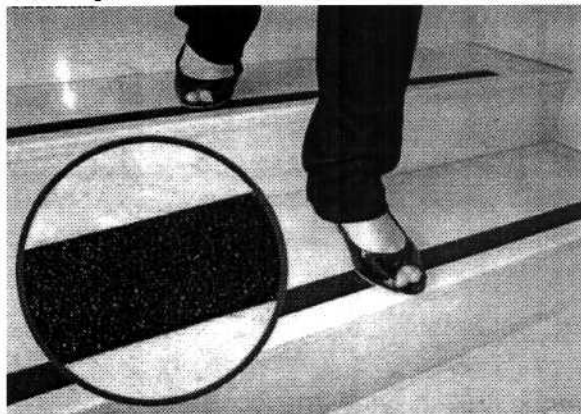
Figura 21: fita antiderrapante instalada em degraus
